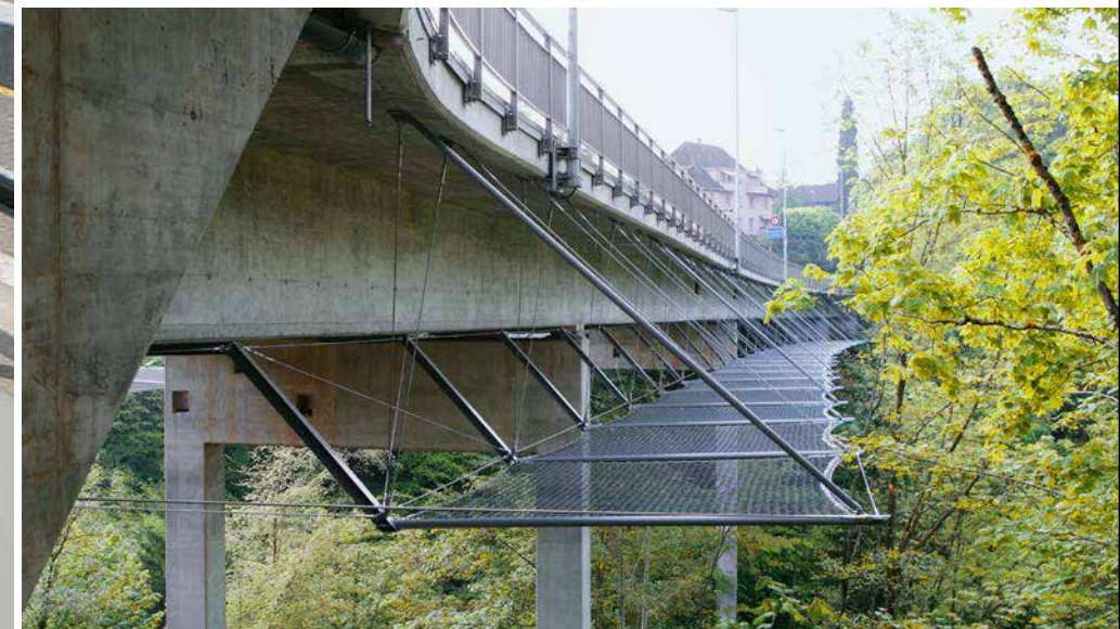
Rotbachbrücke, Rothenburg (CH)
