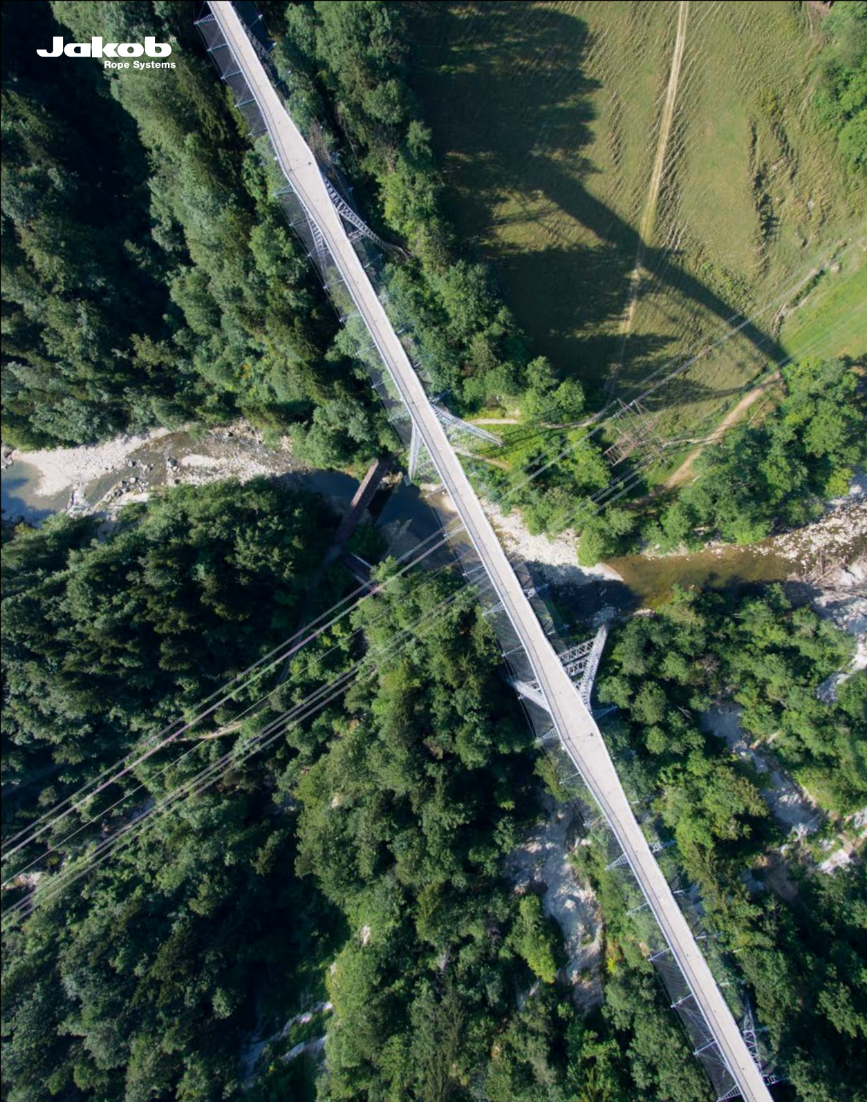
Hagggenbrücke, St. Gallen (CH)
